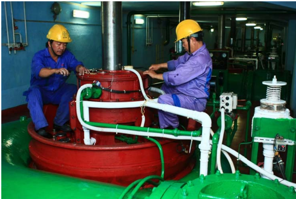
Công tác tại hiện trường (Nguồn: EVNHPC DHD)
