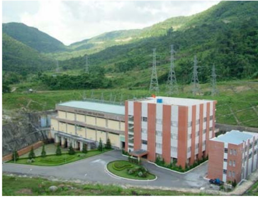
Nhà máy thủy điện Hàm Thuận
