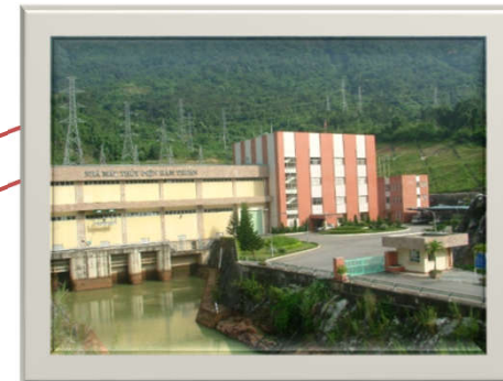
Nhà máy Hàm Thuận
