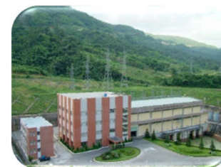
NHÀ MÁY HÀM THUẬN
